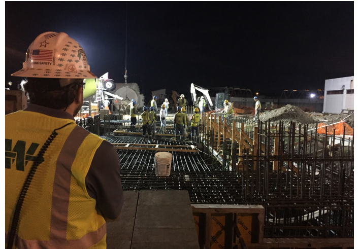
Garland Biosolids concrete pour
